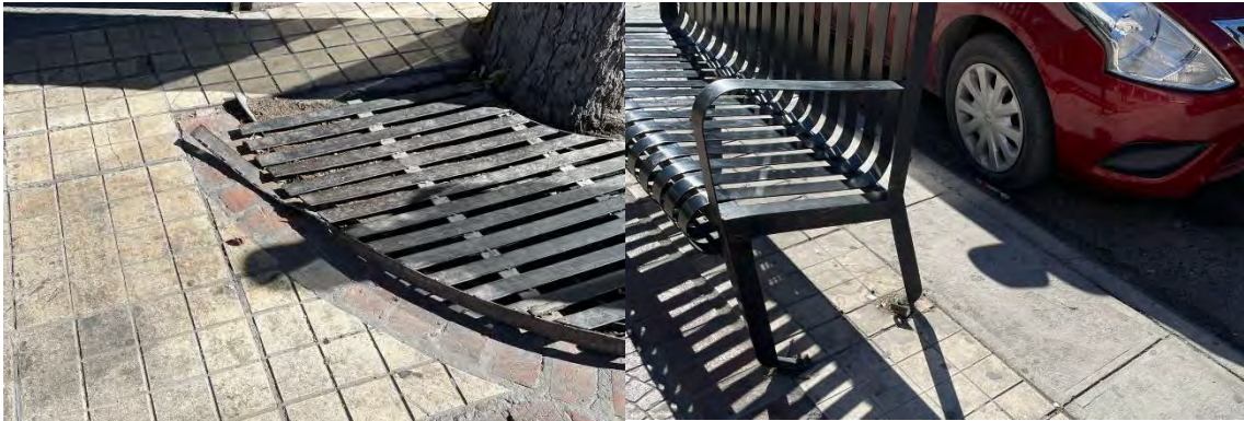
Imagen 9. Ejemplos de Mobiliario Urbano Destruído. Se aprecia como la protección del árbol y la banca presentan daños y representan un peligro para los usuarios.
