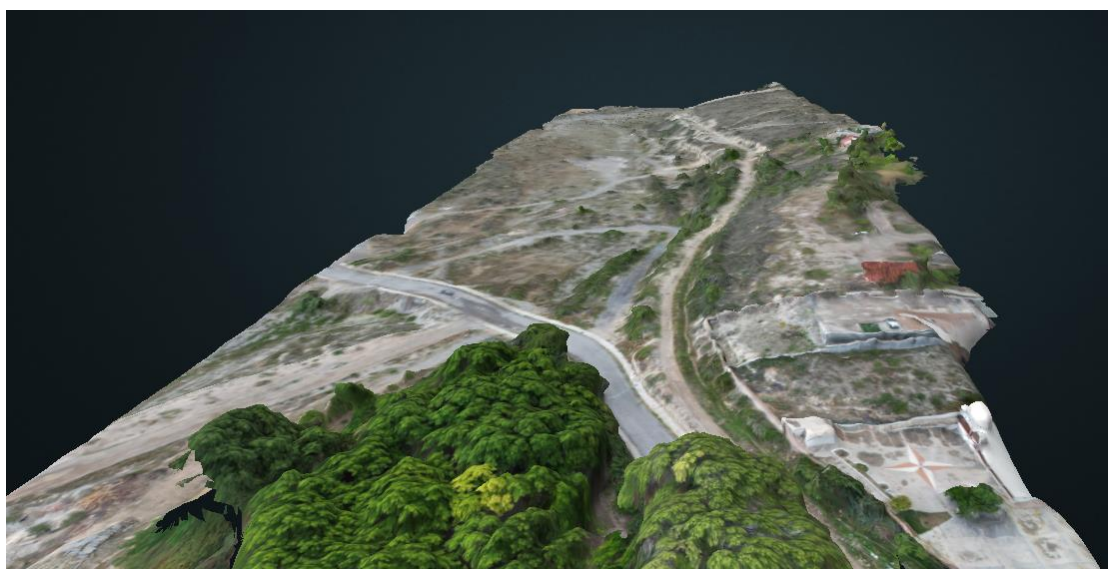
Imagen 36.- Modelo 3D, de la calle Miguel Hidalgo en su parte de terracería, se observa de lado izquierdo un talud de alta pendiente
